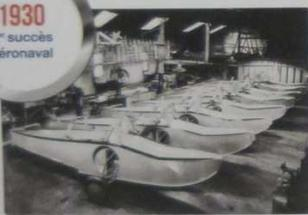
Floteur amphibie G1 doté d'un train d'atterrissage escamotable et d'une crosse d'appontage. Les hydravions pouvaient être employés à bord des cuirassés et des porte-avions de l'US Navy.
