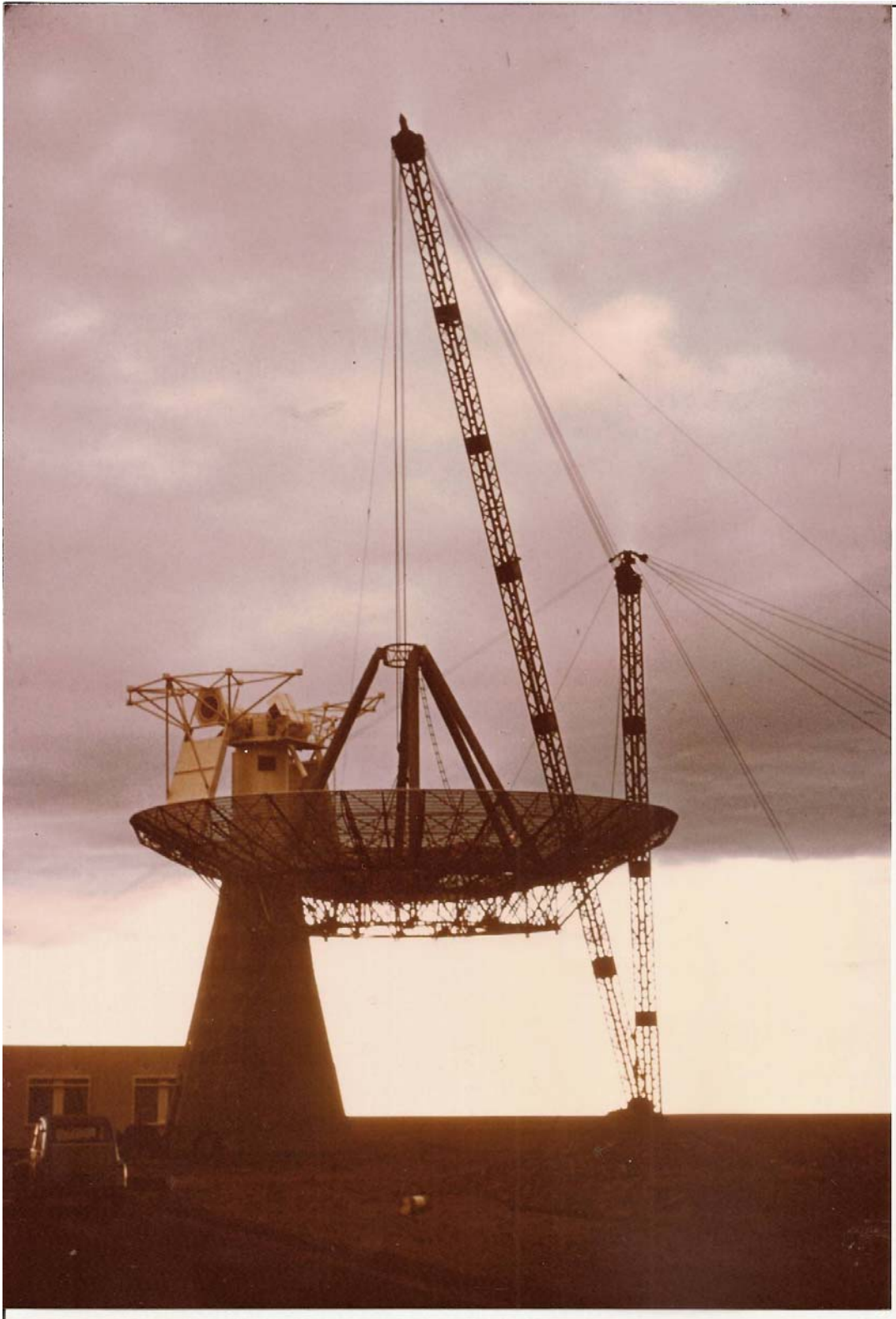
Fig 1 Hammaguir 1964 Mise en place du réflecteur de l'antenne de réception des télémesures Cyclope 1
