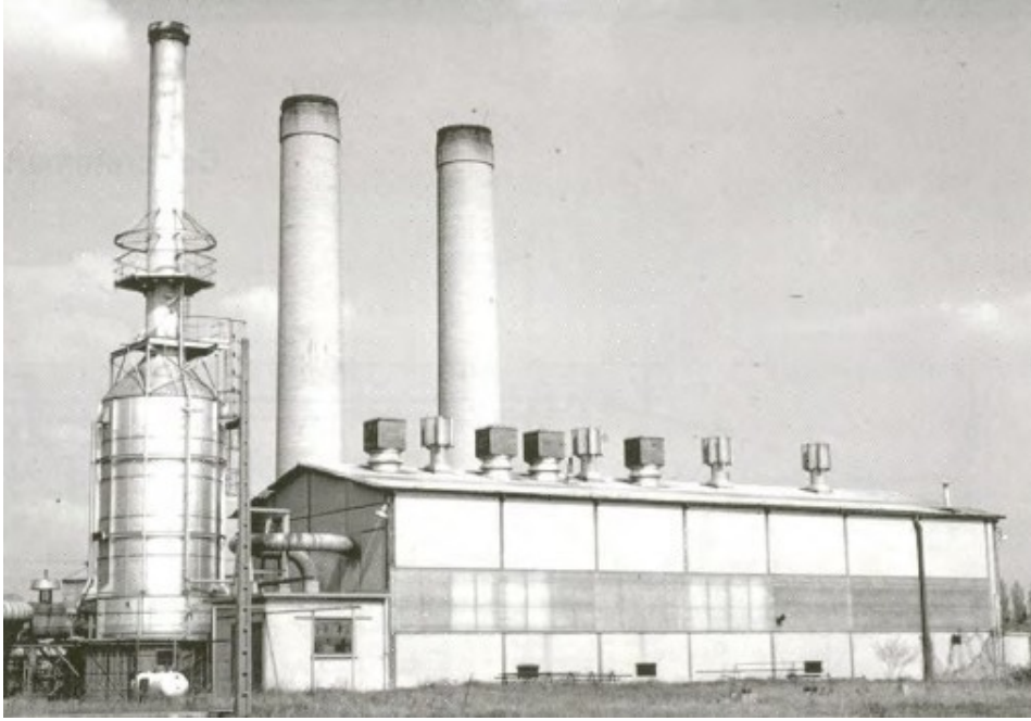
Fig. 7 La chaufferie 2 (chaudières du Montcalm )
