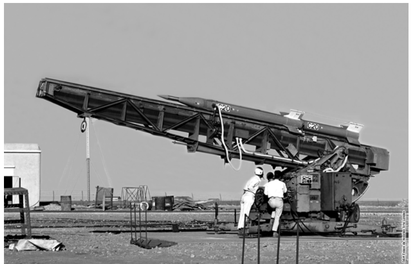
Fig. 14 Centaure, fusée-sonde à poudre de Sud-Aviation lancée depuis Bacchus
