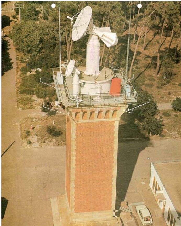
Fig. 16 Le phare désaffecté d'Houert à Hourtin A son sommet, des antennes Antarès. A l'origine, il était coiffé par une antenne Télémaque.
