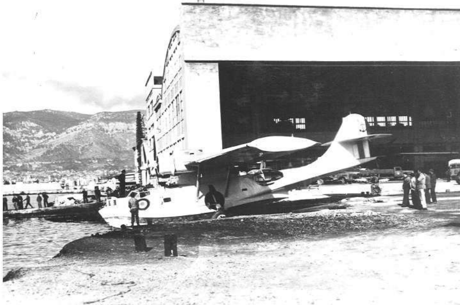
PB5A Catalina sur le slip de mise à l'eau au Mourillon
